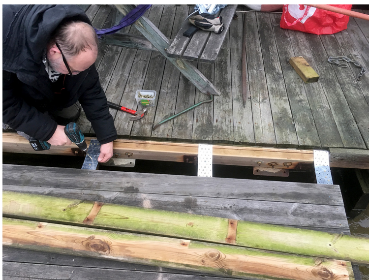
Vi lappade ihop det så gott vi kunde och passade även på att fiska upp bom nr 10. Hela överliggaren som bommen är fäst vid har lossnat från bryggan. Den satt med endast sex spikar som rosta av.
