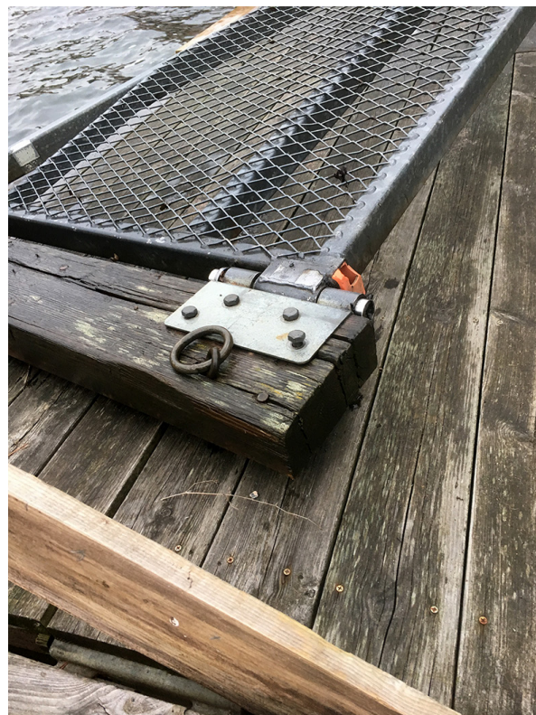
Vi lappade ihop det så gott vi kunde och passade även på att fiska upp bom nr 10. Hela överliggaren som bommen är fäst vid har lossnat från bryggan. Den satt med endast sex spikar som rosta av.
